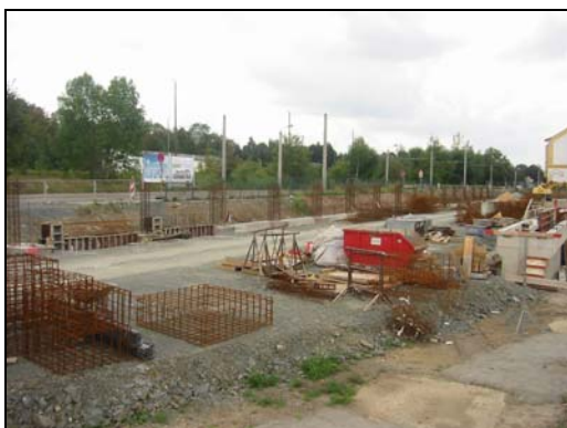
Bauphase – Fundamentarbeiten Abstellhalle Blickrichtung stadtauswärts
