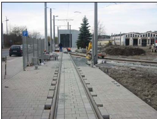
Bauphase – Pflasterarbeiten Gehweg- und Gleisbereich Blickrichtung stadtauswärts zu Ausfahrt Abstellhalle
