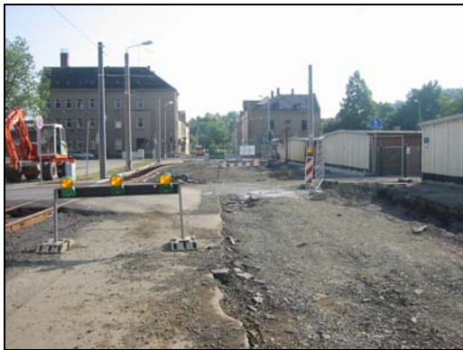
Bauphase – Aufbrucharbeiten Wiesenstraße Zufahrt zu Straßenbahnbetriebshof Blickrichtung stadteinwärts
