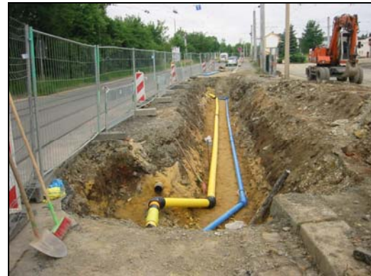
Bauphase – Rohrverlegearbeiten Blickrichtung Wiesenstraße stadtauswärts (rechtsseitig zukünftiger Standort Abstellhalle)
