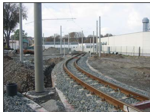
Bauphase – Gleisverlegearbeiten im Betriebshofgelände
