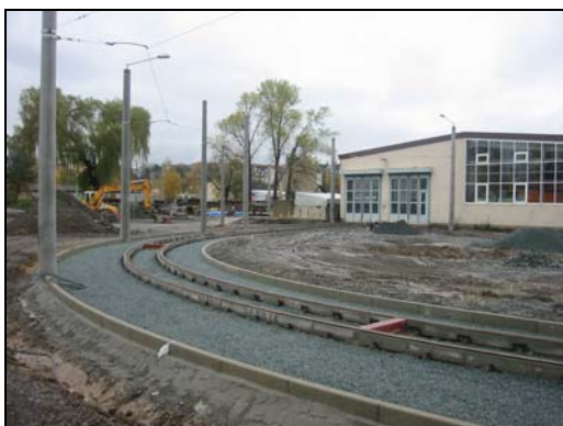
Bauphase – Gleisverlegearbeiten im Betriebshofgelände Blickrichtung zu Werkstatt
