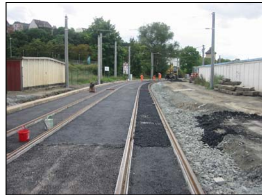
Bauphase – Wiesenstraße – neuerlegte Straßenbahngleise und Asphaltarbeiten Zufahrt zu Straßenbahnbetriebshof Blickrichtung stadtauswärts
