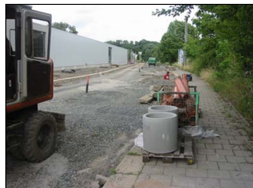
Bauphase – fertige Abstellhalle, Straßenbauarbeiten Wiesenstraße Blickrichtung stadteinwärts
