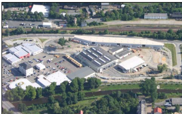
Luftbild – Straßenbahnbetriebshof nach Baufertigstellung
